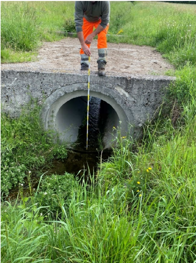
Foto 1.9 – 1.10 – Tratto 1: Vista attraversamento tra Via Pradonici e confluenza in T. Bevera ( \varnothing 1000 mm)
