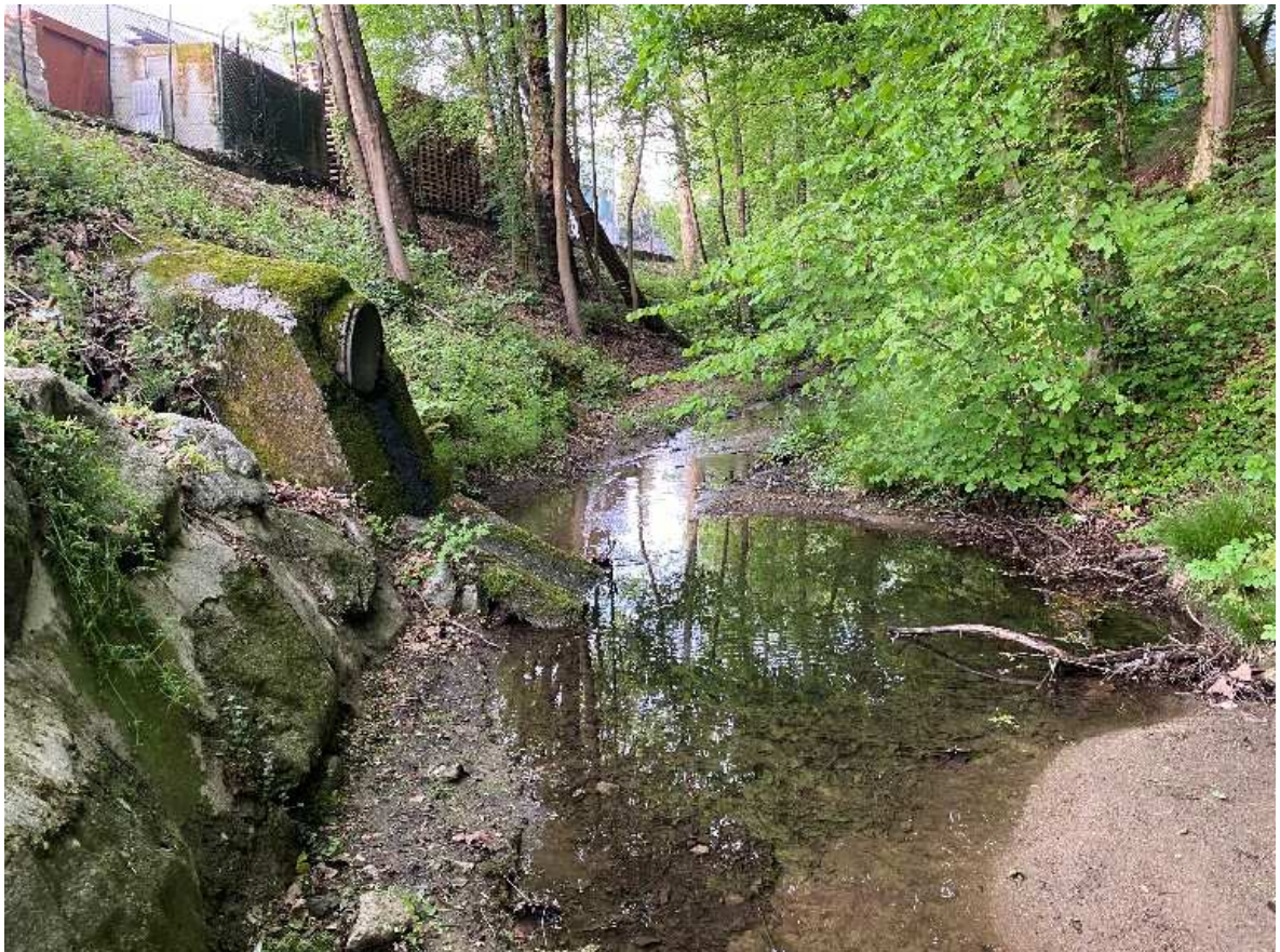
Foto 2.9 – 2.10 – Tratto 2: Vista alveo zona industriale
