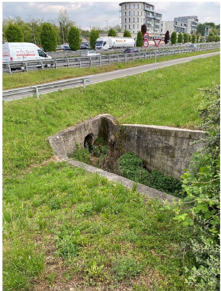
Foto 3.8 – 3.9 – Tratto 3: Vista imbocco (a sx) e uscita (a dx) sottopasso F.S. e S.S. 36 (Ø 800 mm)
