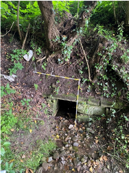
Foto 1B.1 – 1B.2 – Tratto 1B: Imbocco sottopasso S.P. 69 (0,50 x 0,55 m) e confluenza in tratto 1A
