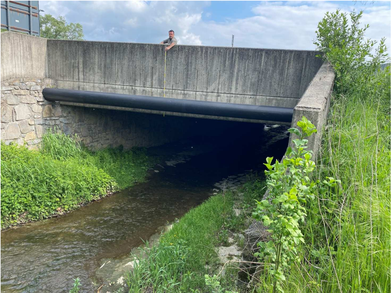
Foto LC002.1 – T. Bevera: Vista imbocco attraversamento rotonda Via Don Allamano (S.P. 52)
