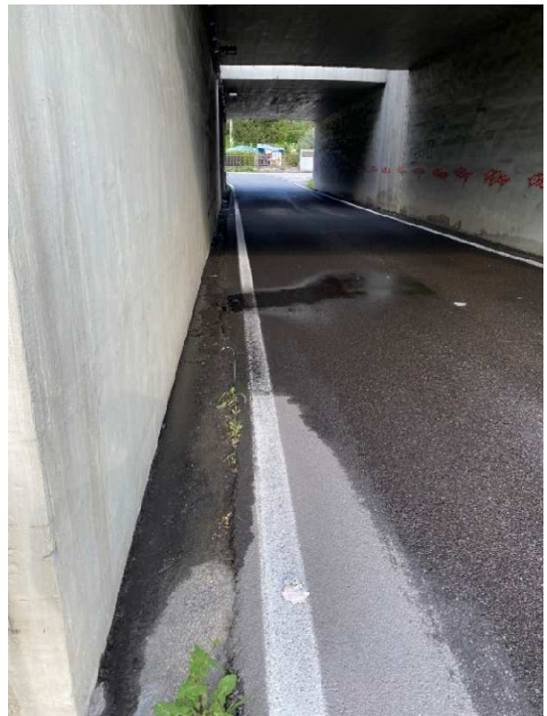
Foto 2.14 – 2.15 – Tratto 2: Vista canale di drenaggio sottopasso stradale S.S. 36 collegato con \varnothing 1500 mm
