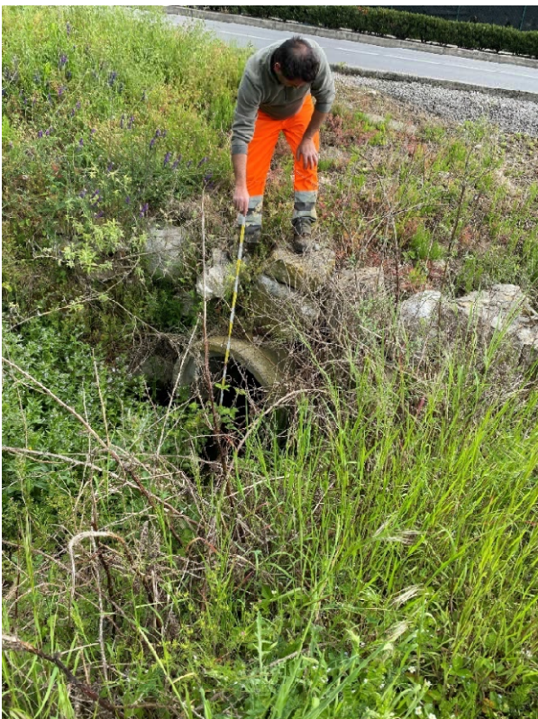
Foto 1C.1 – Tratto 1C: Vista imbocco sottopasso Via Trento (Ø 800 mm)
