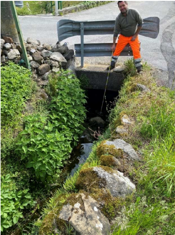
Foto 1.4 – 1.5 – Tratto 1: Vista imbocco (a sx) e uscita (a dx) sottopasso Via Prina (1,0 x 0,9 m)
