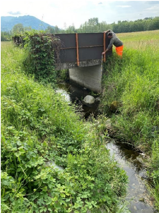
Foto 1.7 – 1.8 – Tratto 1: Vista attraversamento da Via Pradonici (2,50 x 1,70 m)
