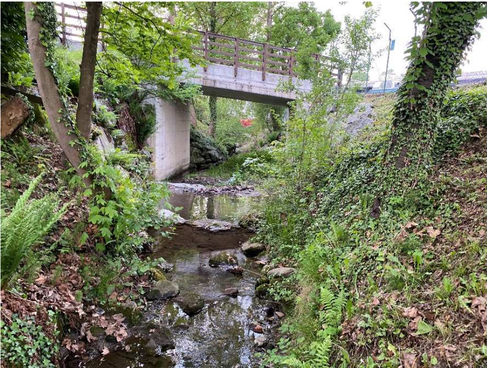
Foto 2.6 – Tratto 2: Vista alveo con attraversamento stradale (luce 6,0 x 4,0 m) a valle Via Italia
