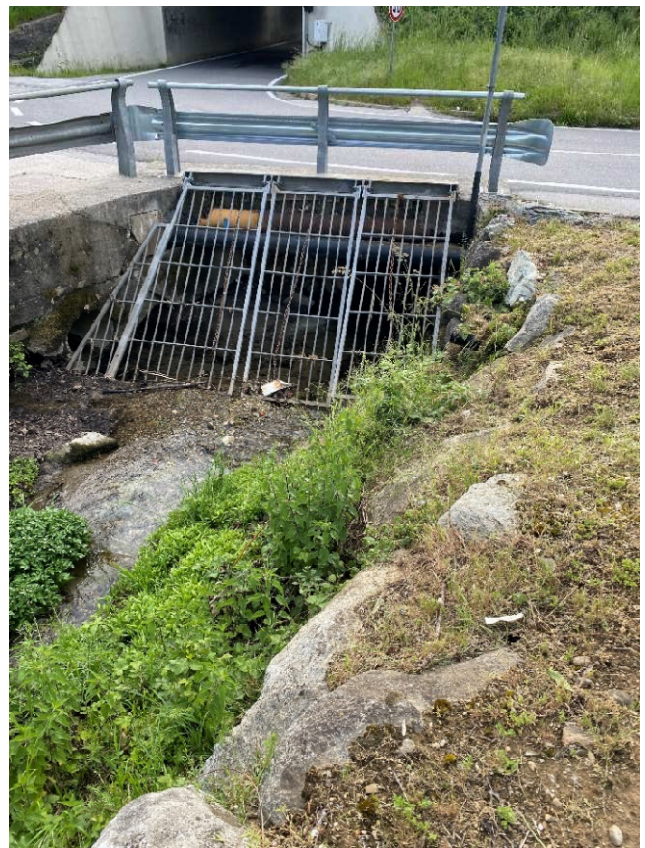
Foto 2.11 – 2.12 – 2.13 – Tratto 2: Vista zona imbocco sottopasso S.S. 36 (Ø 1500 mm)
