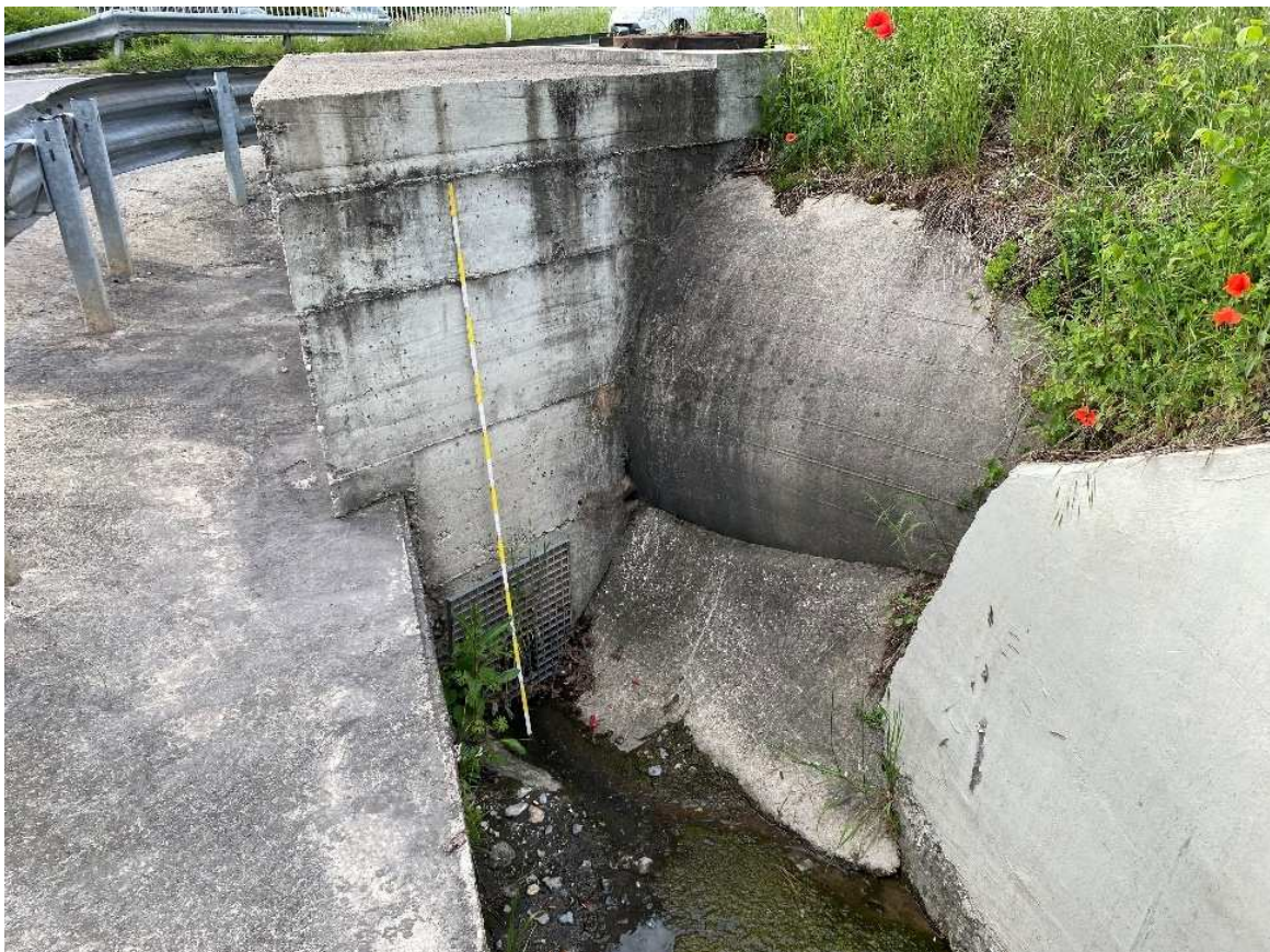
Foto 2.16 – Tratto 2: Vista scarico canale di drenaggio sottopasso stradale S.S. 36 collegato con \varnothing 1500 mm
